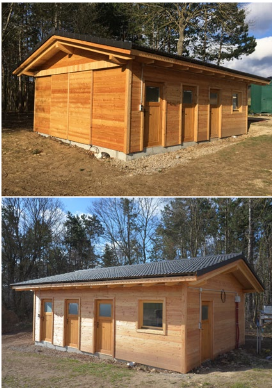
Das neue Testgebäude des Messerli-Freiland Schweinelabors von außen.
